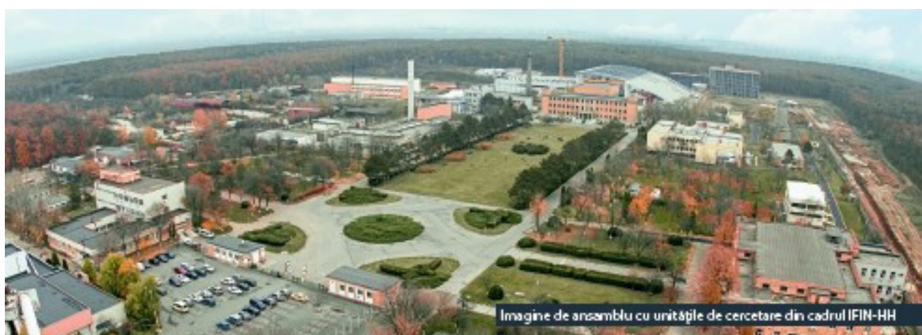
Фиг.1. Общ поглед върху комплексите на ИФИН-ХХ и ЕЛИ-НП. Сградите на ЕЛИ-НП са разположени зад постройката на Изследователския реактор (в розово, непосредствено след парка). Халето на експерименталния комплекс ЕЛИ-НП ще бъде свързано с реакторната зала, която се предвижда да се използва в бъдеще като част от лабораторния комплекс.
